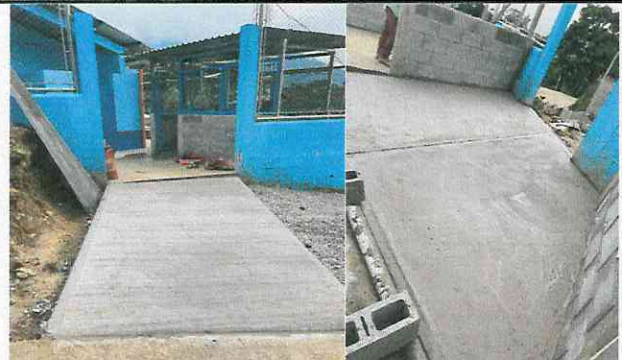
Foto 6: Sustitución de torta de cemento en mal estado
