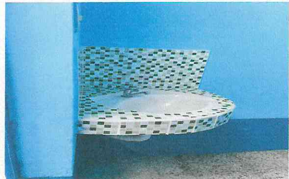
Foto 4: Cambio de 3 lavamanos con sus respectivos accesorios, colocación de azulejos en lavamanos
