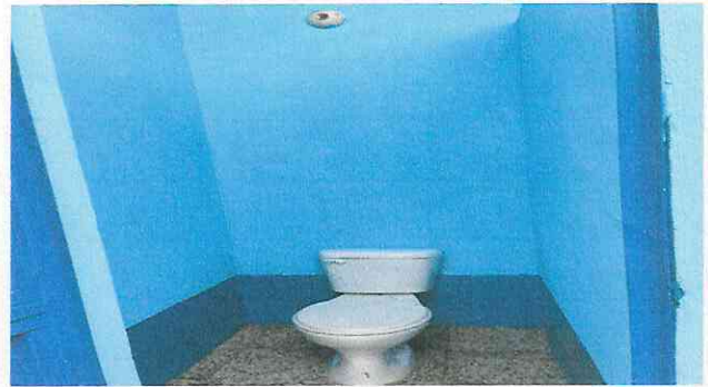
Foto 2: Cambio de 2 baños sanitarios con sus respectivos accesorios e instalación de azulejos.
