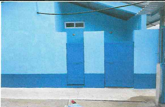
Foto 5: Sustitución de pintura de baños
