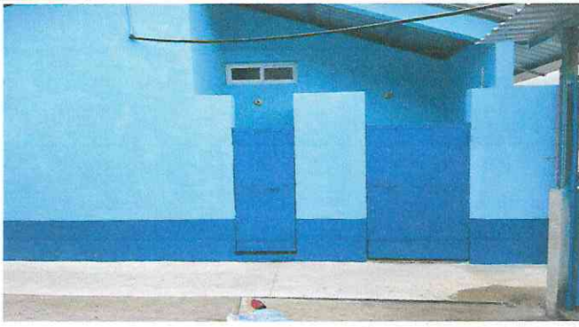
Foto1: Reparación de 2 puertas de baños (Limpieza, Soporte y pintura)
