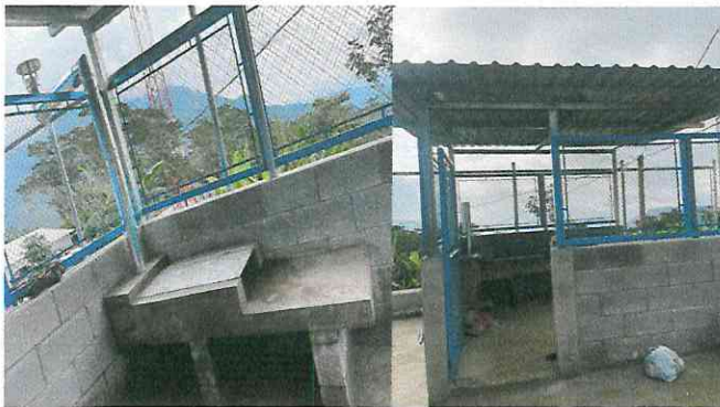
Sustitución de estufa rural, incluyendo, polleto y chimenea, sustitución de techo de madera por estructura metálica, cerramiento de alrededor de cocina a 1 metro de alto
