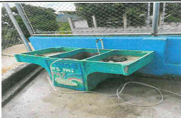
Foto 9: Colocación de tubería para agua y drenaje para pila.
