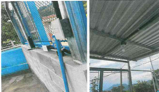
Foto7: Sustitución de suministro de electricidad en cocina.
