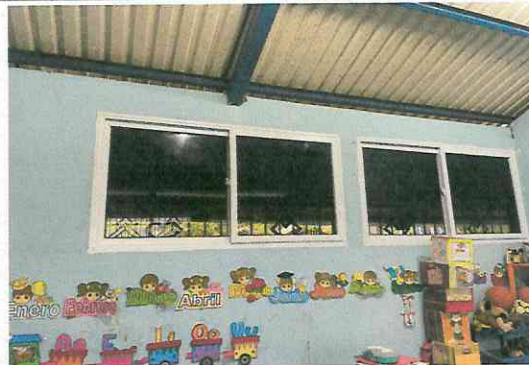
Foto 8: Sustitución de ventanas a ventanas PVC
